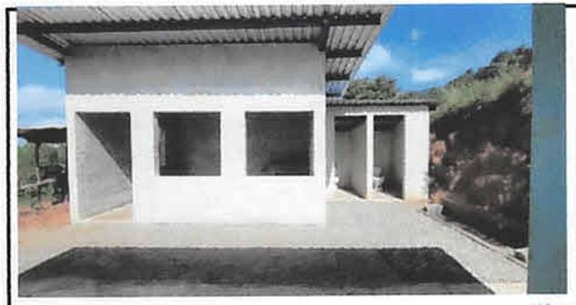
FOTO 6: Repello e instalación de sanitarios
